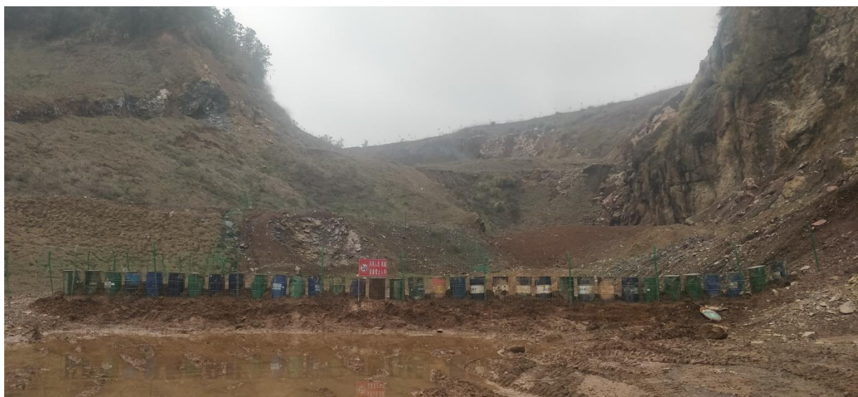
图 2.6-2 老采坑挡墙及围栏
