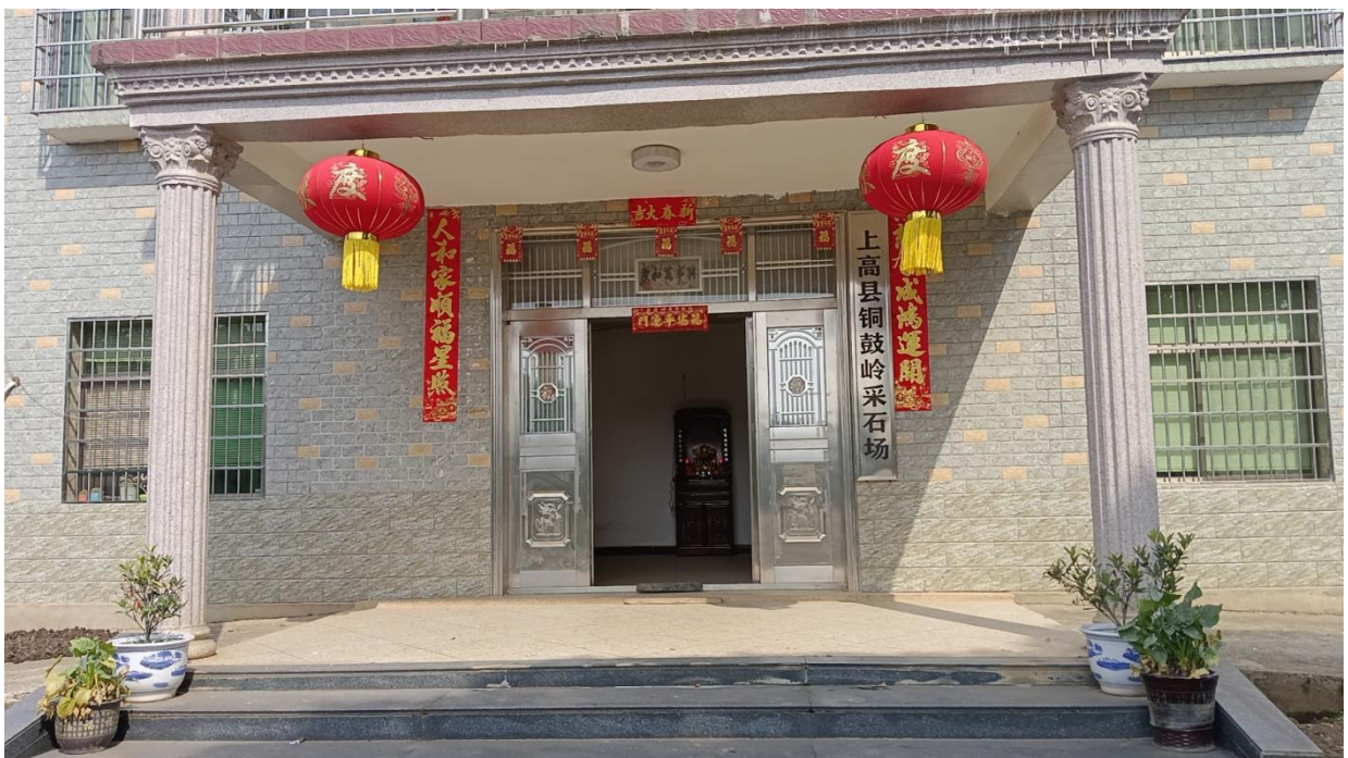
图 2.6-2 矿山磅房及值班室
