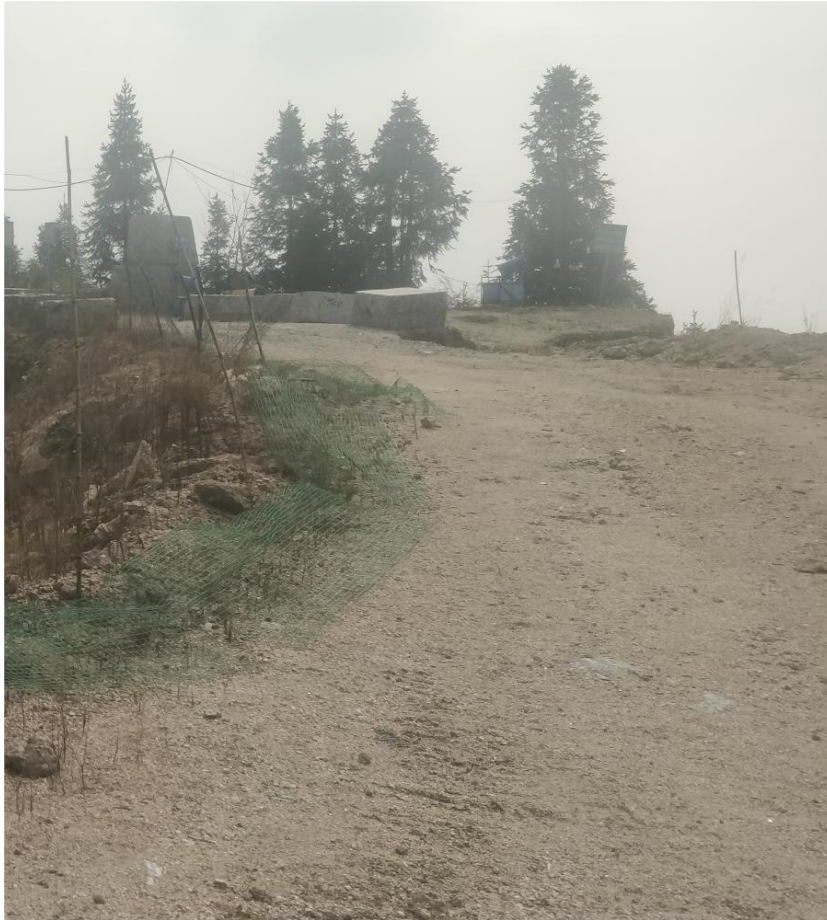
图 2.6-5 矿区运输道路
