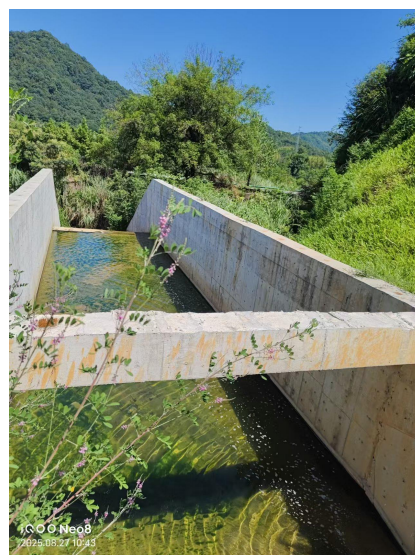
图 2-7 溢洪道末端的消力池
