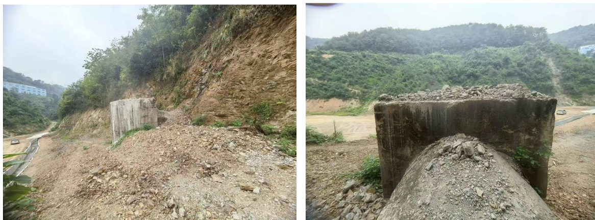
图 2-8 现有排洪设施封堵、排水井井座封堵及排水井井座拆除
