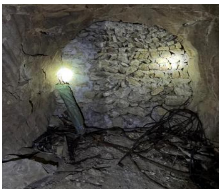
图 2-2 采空区封堵墙
