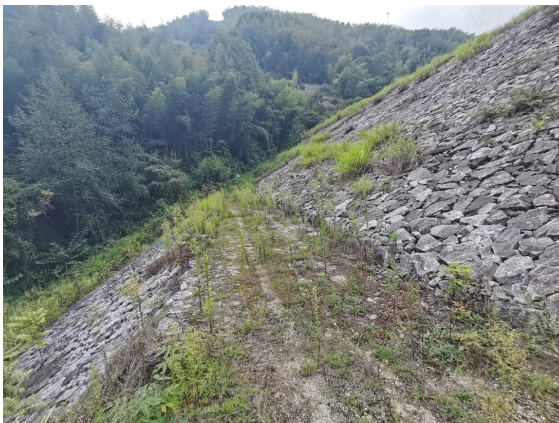
图 2-4 尾矿库初期坝下游坡面
