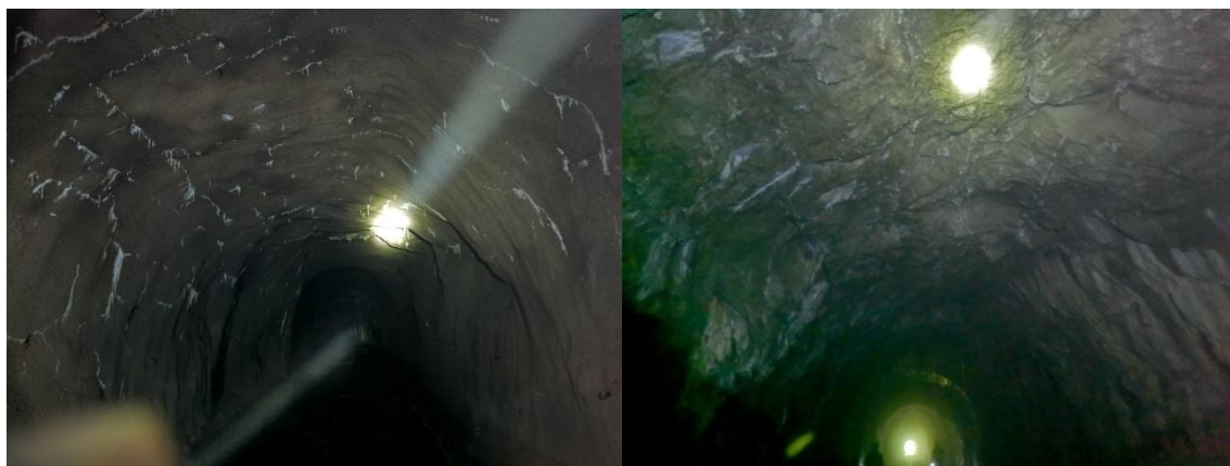
图 2-8 隧洞内未衬砌段
