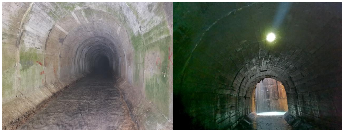
图 2-7 隧洞内衬砌段
