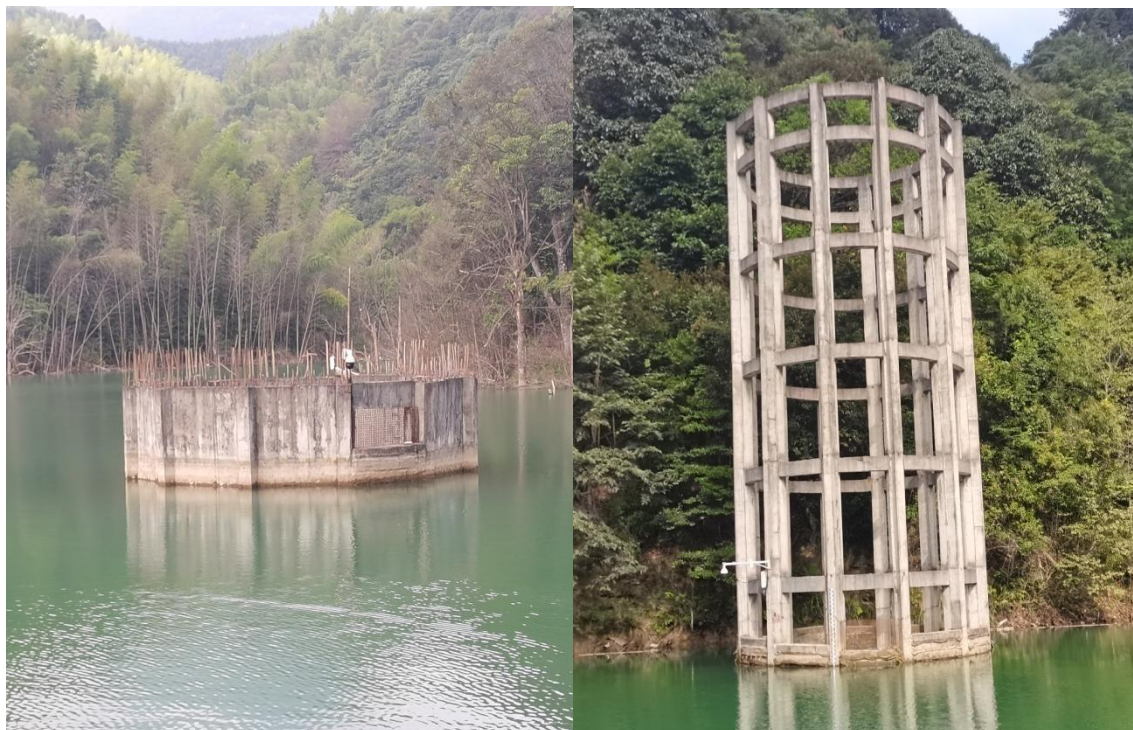
图 2-6 1号排水井和 2号排水井
