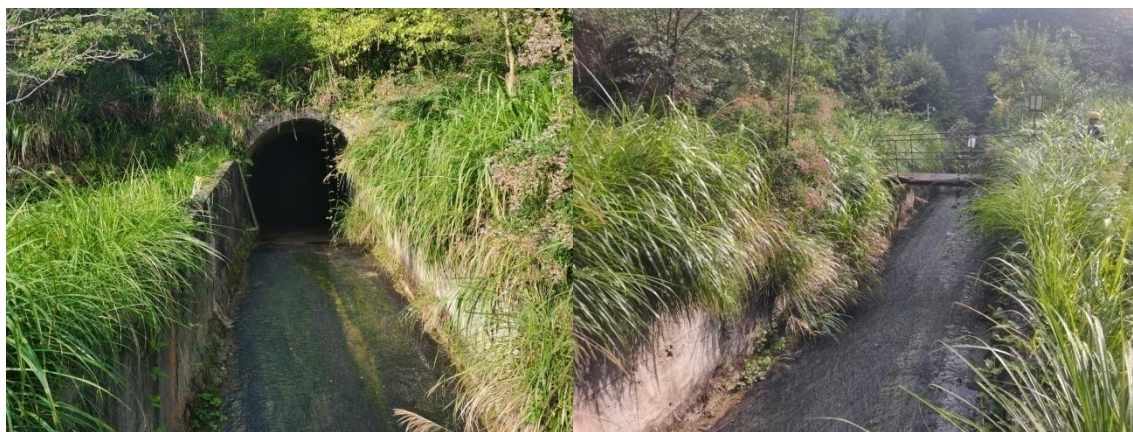
图 2-9 隧洞出口与明渠
