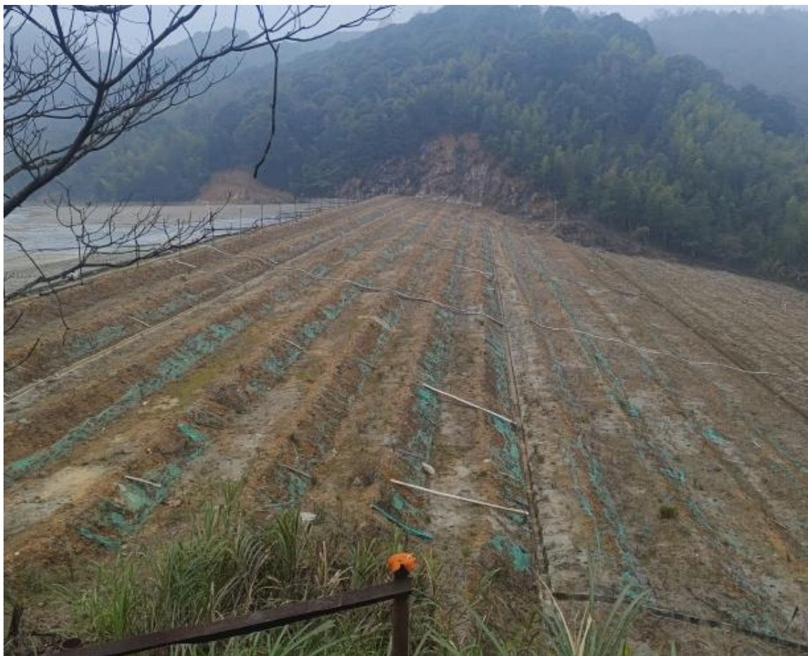
图 2-5 尾矿堆积坝下游坡面
