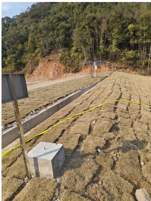
位移观测设施
