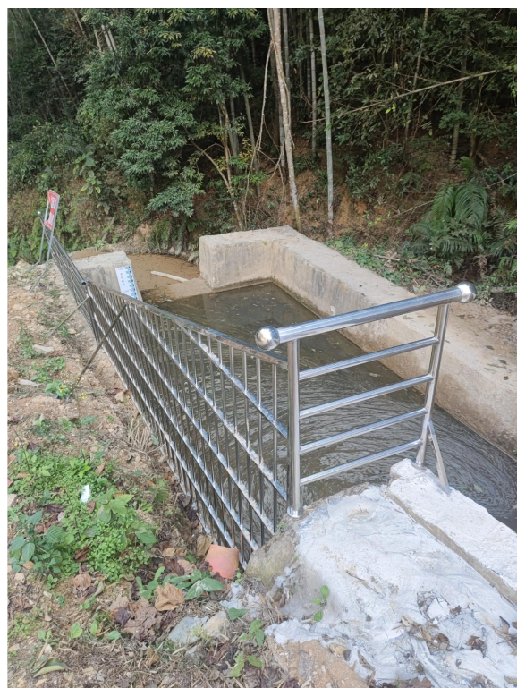
图 2-19 消力池、渗滤液收集池及护栏
