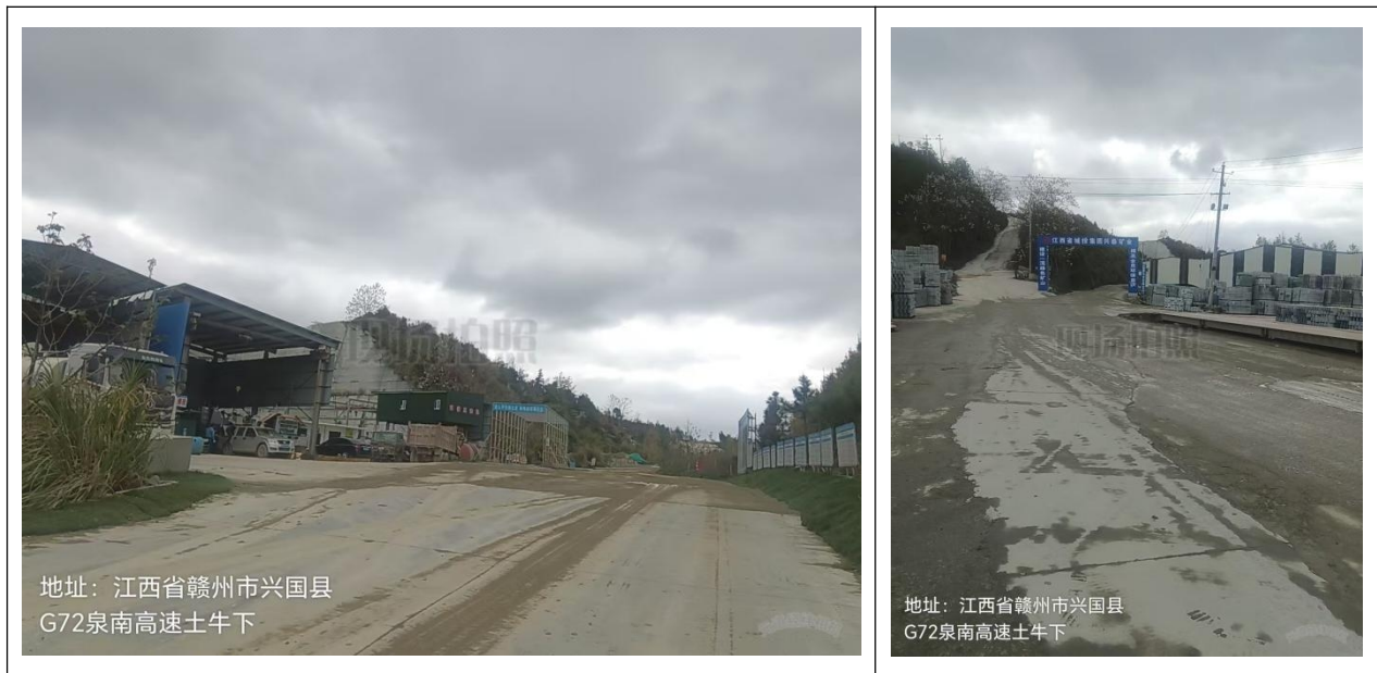
图 2.5-4 矿区运输道路
